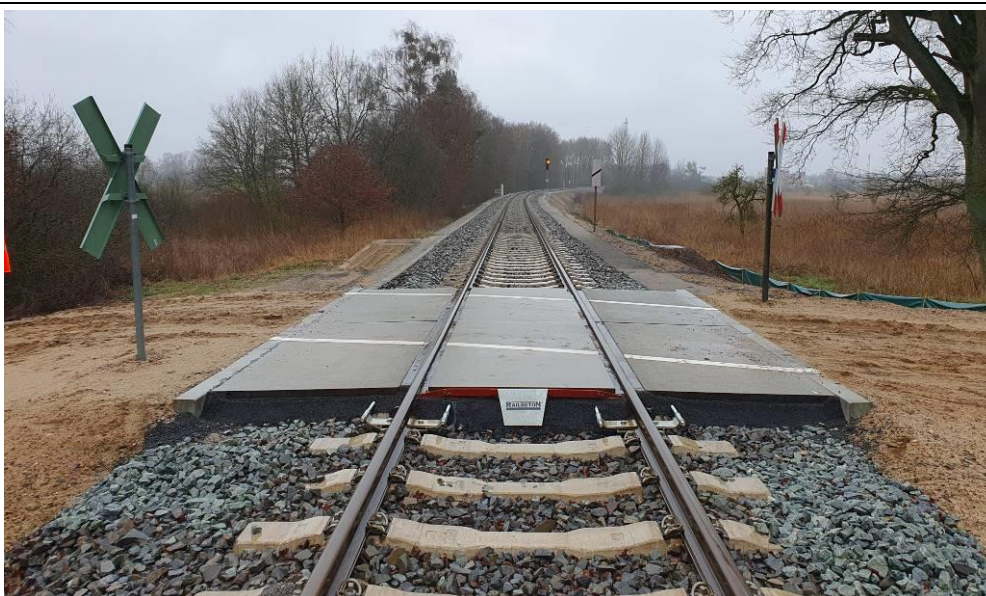
Abbildung 5: Gleiseindeckung mit Großflächen- platten
