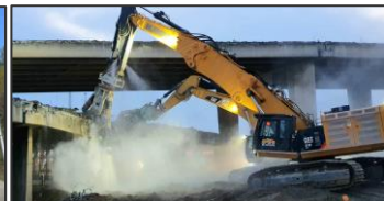
Rückbau der bestehenden Brücke B207 (Bild) – Sperrung 48h (Wochenendsperrung außerhalb Hochsaison)
