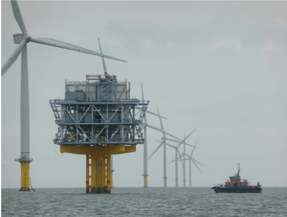
Rysunek 3.6 Przykładowa morską stacją elektroenergetyczną
