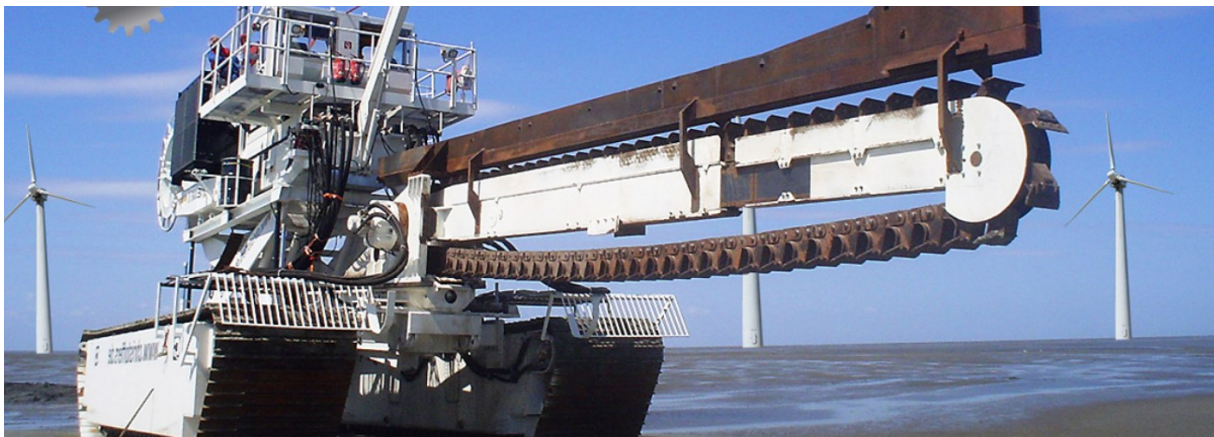
Figur 3.14. Anordning för nedgrävning av kablar på havsbotten. Källa: https://www.barthollandrain.nl/page/161
