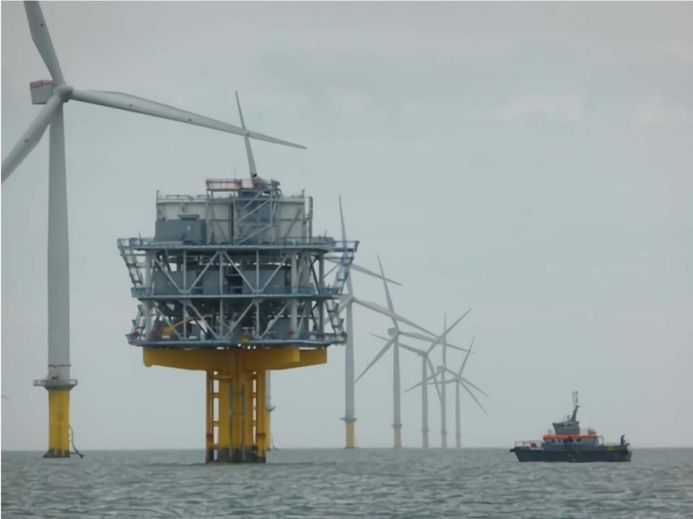
Abbildung 3.6 Beispiel für ein Offshore-Umspannwerk
