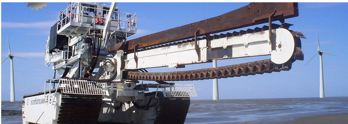
Abbildung 3.14 Ein Gerät zum Vergraben von Kabeln im Meeresboden. Quelle: https://www.barthollandrain.nl/page/161 .
