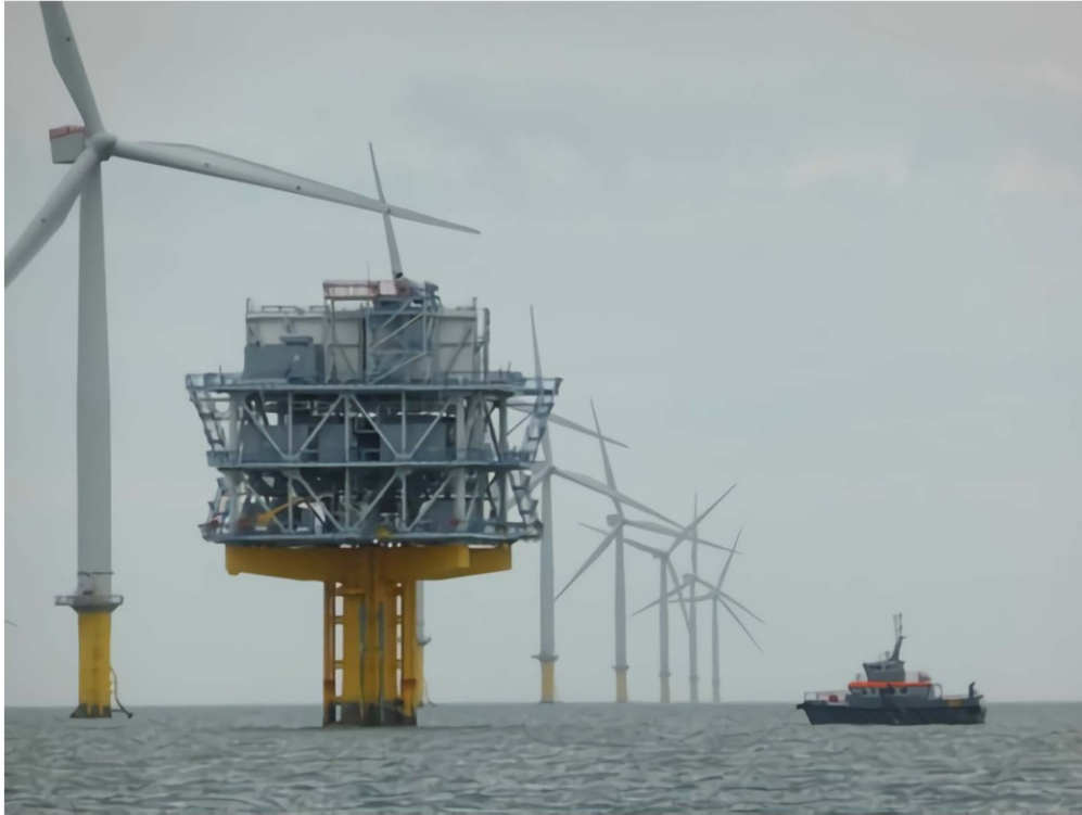
Abbildung 3.6 Beispiel für ein Offshore-Umspannwerk
