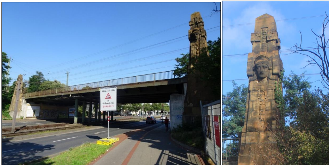
Abbildung 19: Fotos der denkmalgeschützten Pylone.
