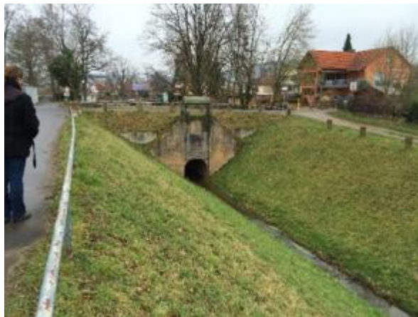
Abbildung 3-4: Hochwassersiel an der Kraftwerkszufahrt/Brücke 2 (Quelle: ARGE)
