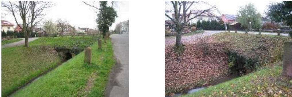
Abbildung 3-7 Brücke 2: Ansichten von Norden (Quelle: ARGE)
