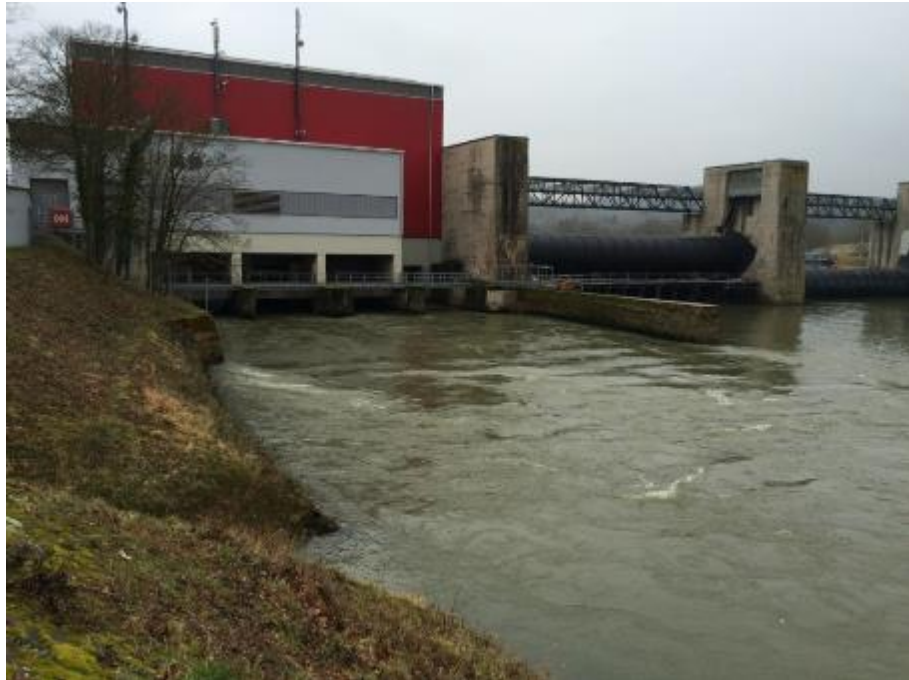
Abbildung 3-3: UW-Ansicht des Kraftwerks Wallstadt, im Vordergrund Mündung des Neuen Grabens (Quelle: ARGE)
