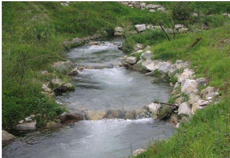
Abbildung 3: Beispiel eines beckenartigen Raugerinnes als Umgehungsgerinne (Quelle: [4])
