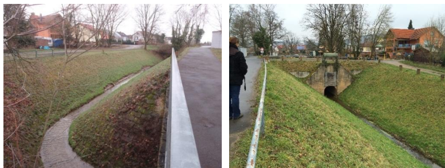
Abbildung 5: Neuer Graben im Kraftwerksbereich an Brücke 1 (li. 19.03.2013) sowie Hochwassersiel an der Kraftwerkszufahrt/Brücke 2 (re. 10.02.2015) (Quelle: Redeker)
